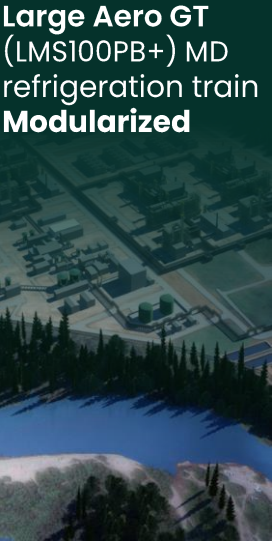
CANADA LNG Under Construction
